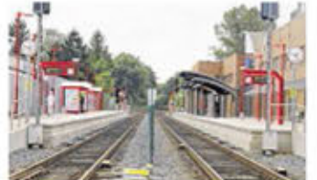
Der Bahnhof in Quickborn: Derzeit ein AKN-Bahnhof, doch bald könnte dort die S 21 halten.
